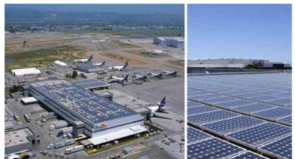
*Système photovoltaïque (904 KW) installé par la société PowerLight sur le toit de la plate-forme logistique de FedEx à Oakland (CA).
