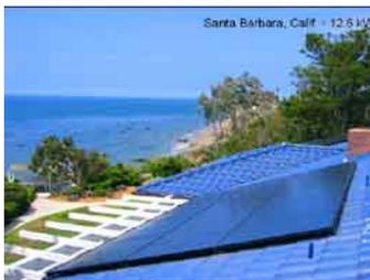
Figure 9. Installation de 12.6 KW (SunPower) sur le toit d'une maison à Santa Barbara en Californie.
