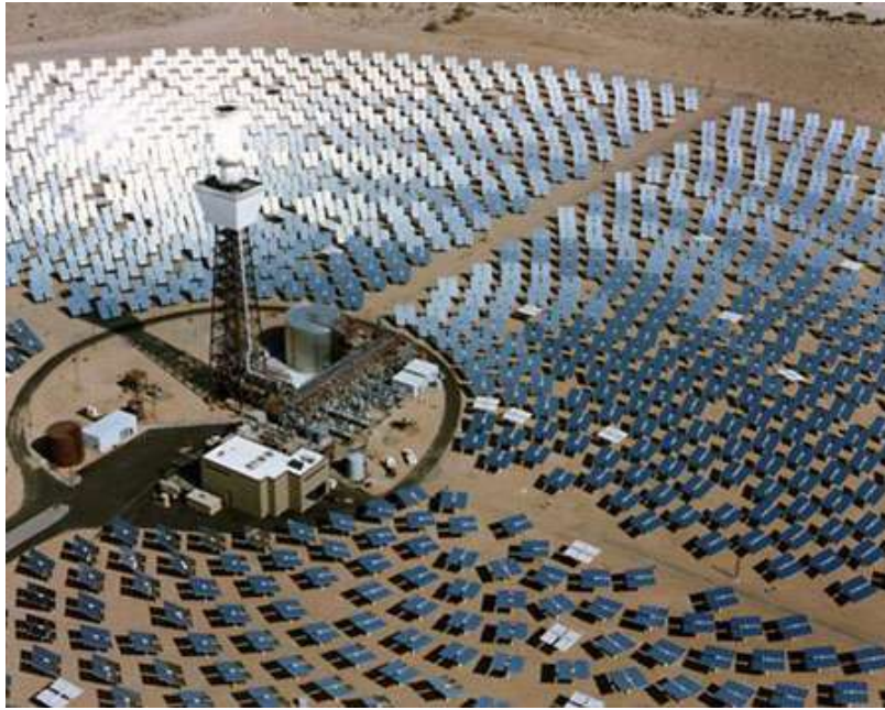
Figure 33 Vue aérienne de Solar Two
