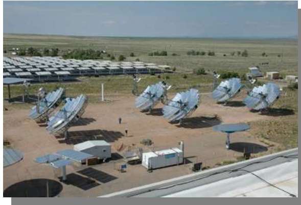
Figure 36 Mini-centrale composée de six systèmes dish-stirling à Sandia (Source : Sunlab)
